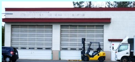
ネギの出荷調整作業施設
